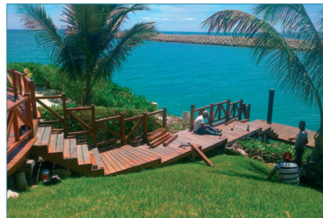
Mantenimiento preventivo y correctivo a barandales de la escalera que lleva al muelle
