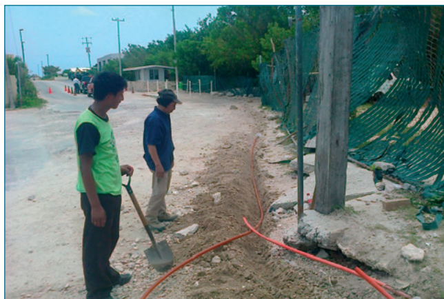
Remodelación eléctrica de la caseta entrada norte.
