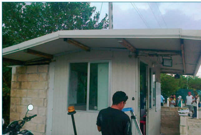
Mantenimiento a caseta de seguridad de la entrada norte.
