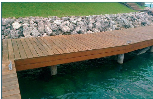
Pintura faldón de muelle del club de playa
