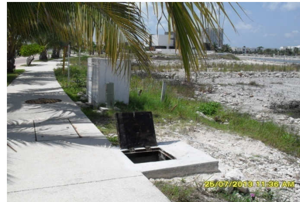
Verificación de puntos de seccionamiento de circuitos
