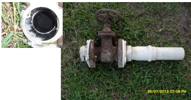
Sustitución de Válvula en mal estado en Mza 12
