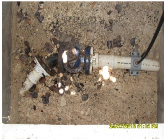
Verificación de puntos de conexión de circuitos
