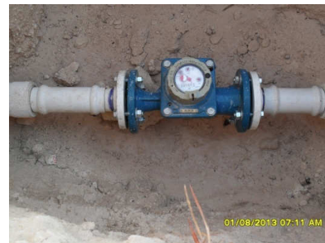
Adecuación de infraestructura para medición de 7 Circuitos
