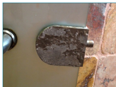
Cambio de cerrojos en puertas de baños y regaderas.
