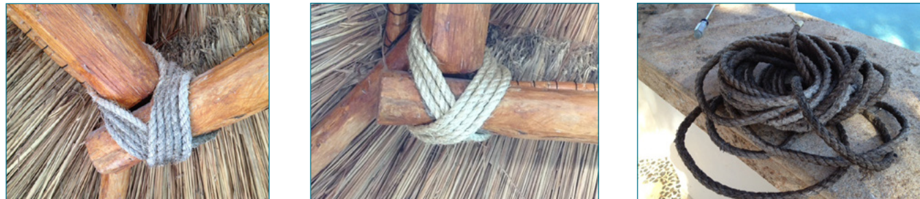
Cambio de henequen en palapa del bar.
