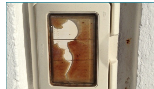
Cambio y mantenimiento de contactos eléctricos.
