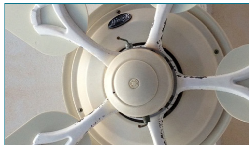
Mantenimiento a ventiladores.
