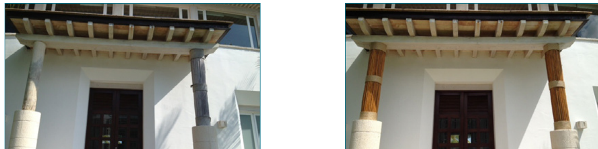
Mantenimiento a bamboo en entrada trasera del Gimnasio.
