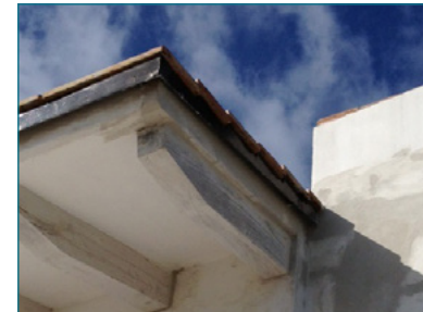
Resane de grietas en restaurante.
